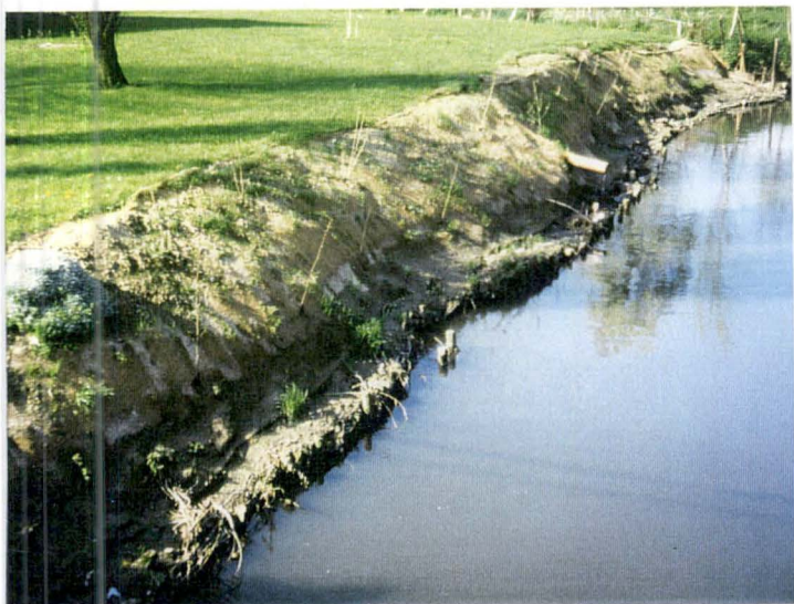
Photo A10 : Fascine réalisée à Boirs, sur le Geer
