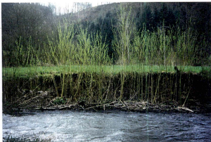
Photo A4 : Tapis de branches de saules réalisé à Ouffet, sur le Néblon
