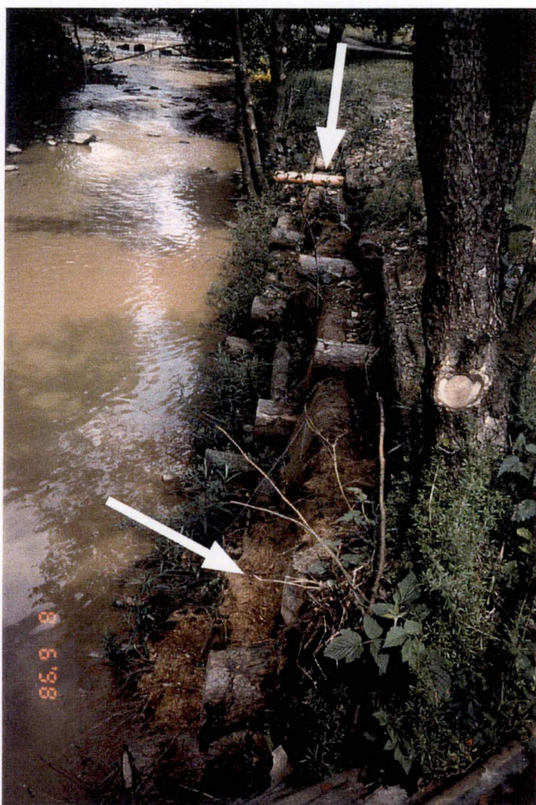
Photo 2: Les flèches montrent les déchets de jardinage et tuyau d'évacuation se trouvant sur le caisson de Schönberg (Juin 98)
