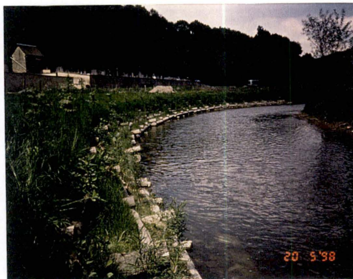
Photo A17 : Caisson réalisé à Martelange, sur la Sûre
