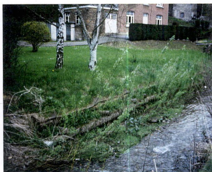
Photo A7 : Caisson réalisé à Plombières, sur la Gueule
