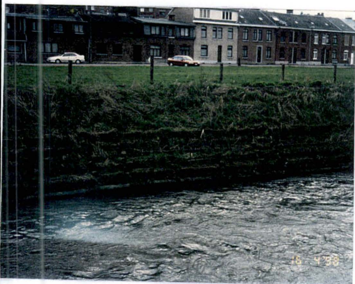
Photo A8 : Caisson réalisé à Stavelot, sur l'Amblève
