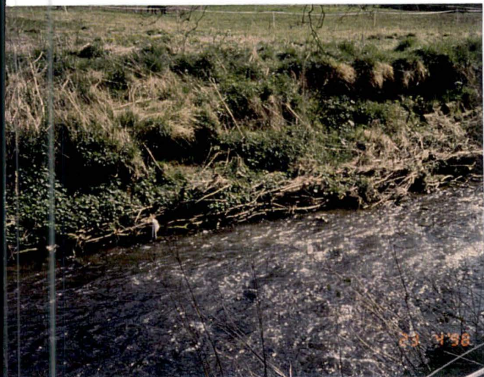
Photo A6 : Fascine réalisée à Plombières, sur la Gueule
