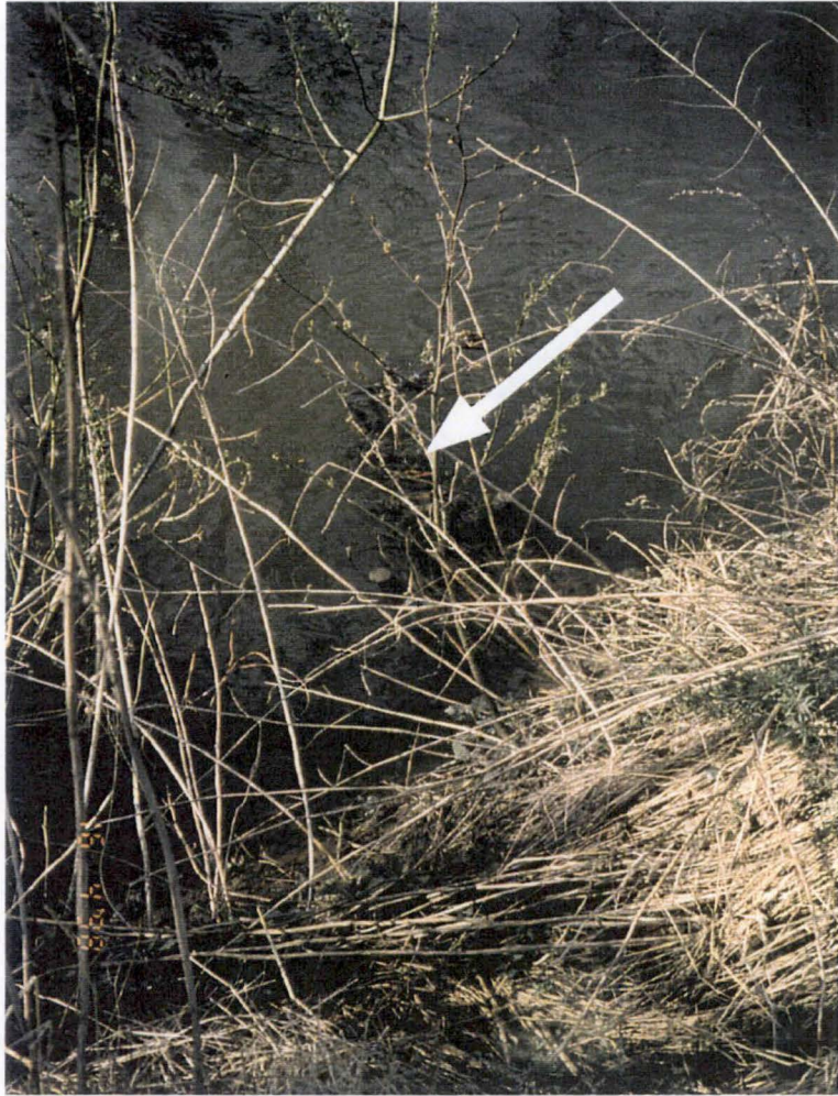
Photo 14: La flèche montre un épis faisant partie de l'aménagement effectué sur la Mehaigne à Fumal.
