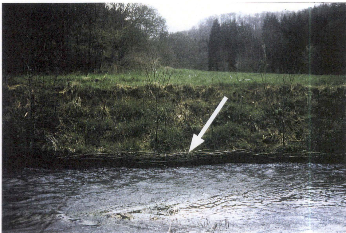
Photo 12: La flèche indique la réalisation des fascines à Ouffet sur le Néblon (Mars 1998).
