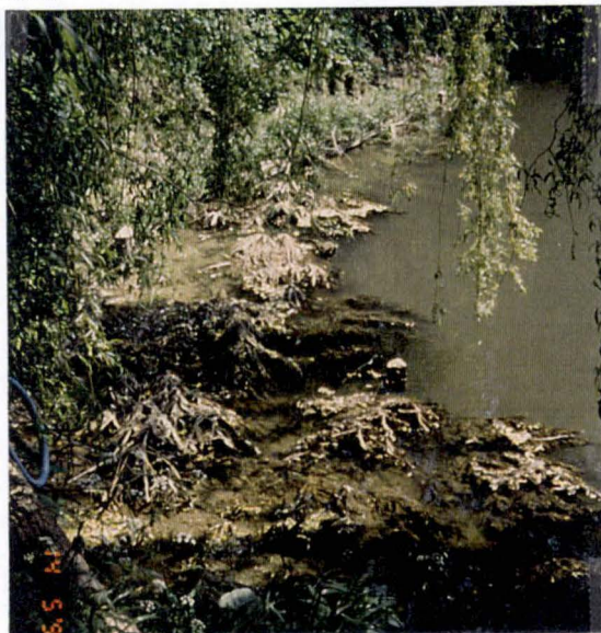
Photo A4 : Tapis de branches de saules réalisé à Ouffet, sur le Néblon
