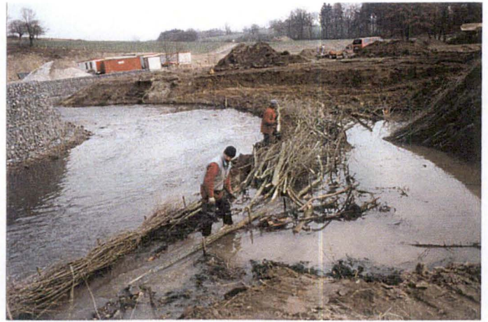
Photo 8: Réalisation des fascines à Plombières (Avril 1996)
