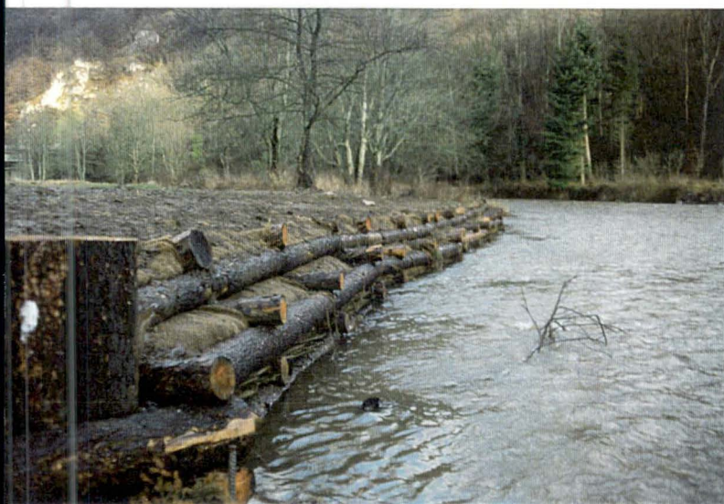
Photo A12 : Caisson réalisé à Furfooz, sur la Lesse
