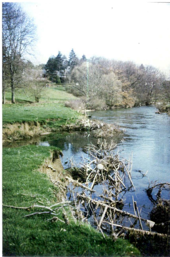
Photo A14 : Peigne réalisé à Eprave, sur la Lesse
