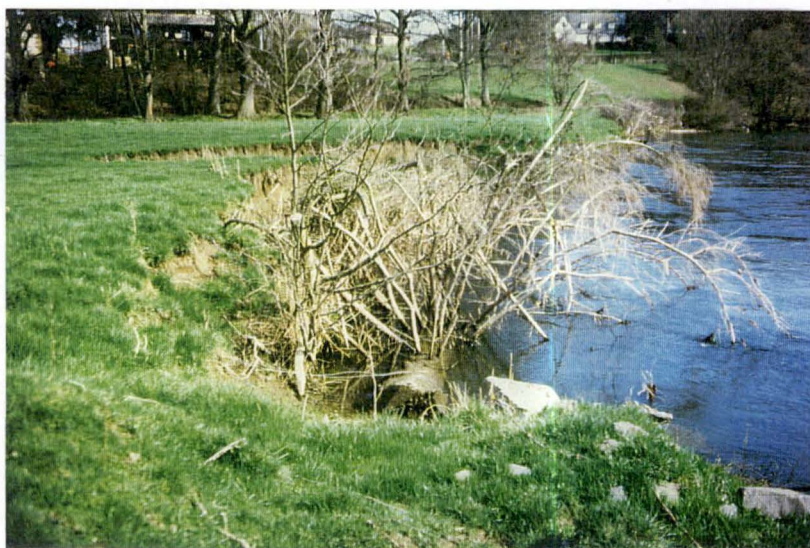
Photo A13 : Peigne réalisé à Eprave, sur la Lesse
