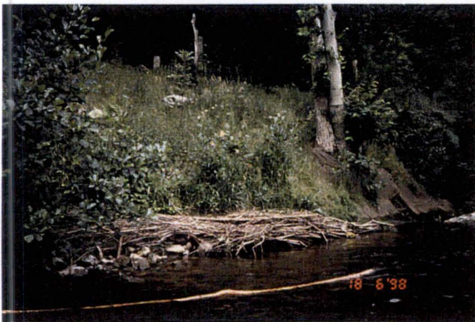
Photo 5: Peigne placé en amont du caisson de Petigny
