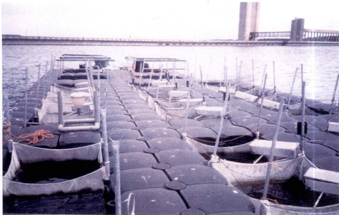
Photo 1: Vue générale du ponton flottant.
