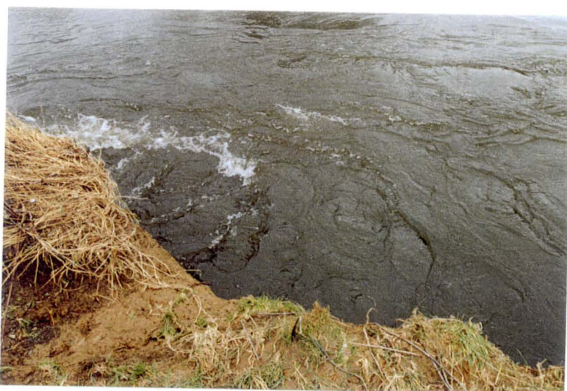
Figure 44 : Représentation de la force érosive du courant contre la berge.
