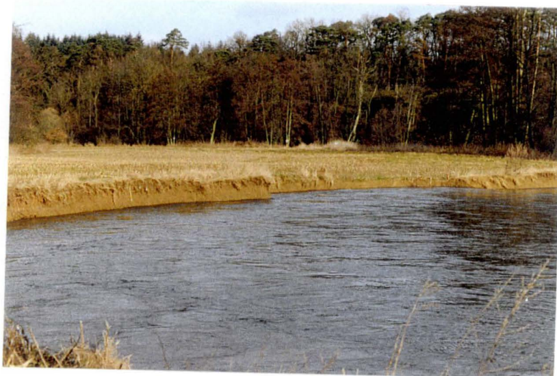
Figure 45 : Photo illustrant la zone la plus érodée à Villers-sur-Lesse.
