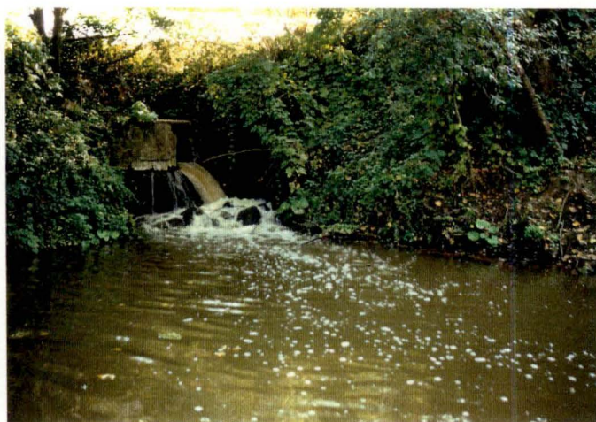
Photo 6. Arrivée d'eau dans la petite noue de Tailfer.
