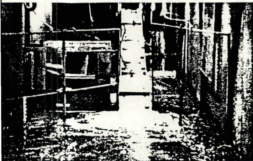
Fig. 29 : Cette échelle DENIL possède un écran grillagé servant à guider le poisson vers l'entrée de la passe (d'après SLATICK, 1975).
