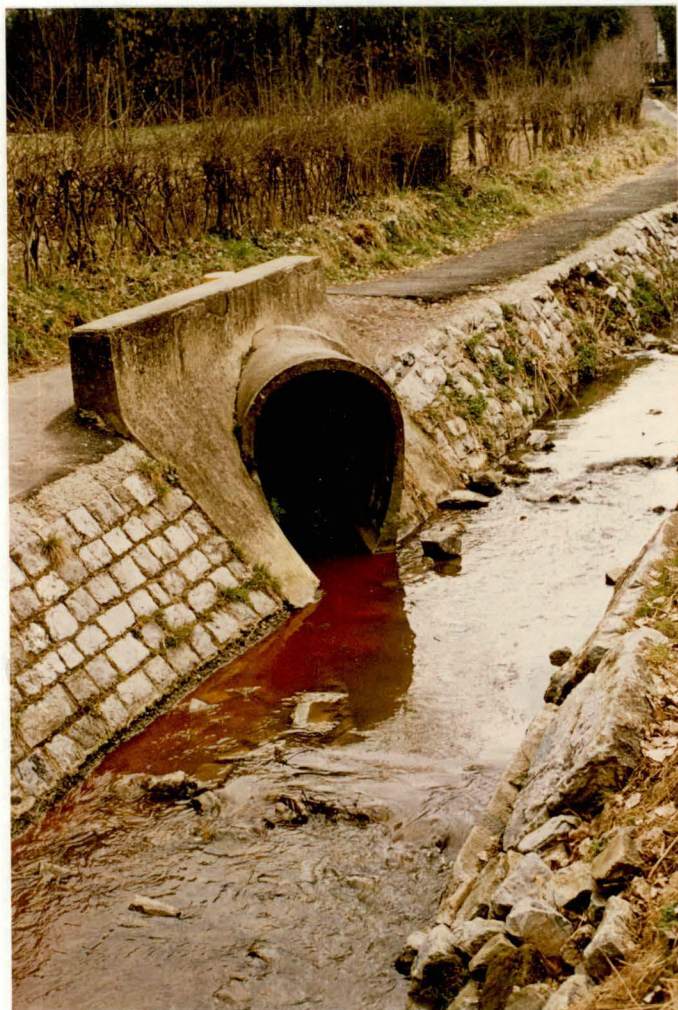
Photos 1 et 2 : Rejets dans la Nefzée : sortie du collecteur d'égouts ( E 6 )
