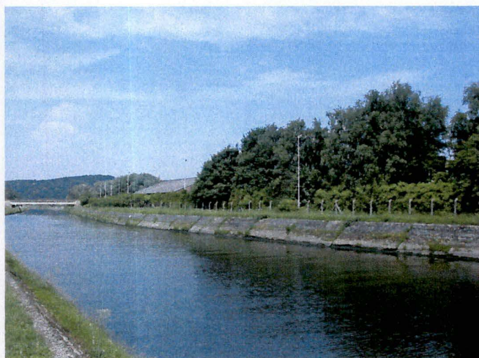
III. Poteaux d'éclairage à Floriffoux
