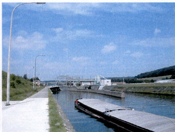
VI. Ecluse de Floriffoux
