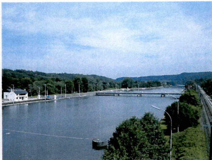
VIII. Ecluse de Tailfer
