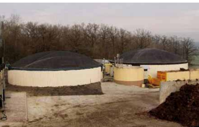
Installation de biométhanisation
