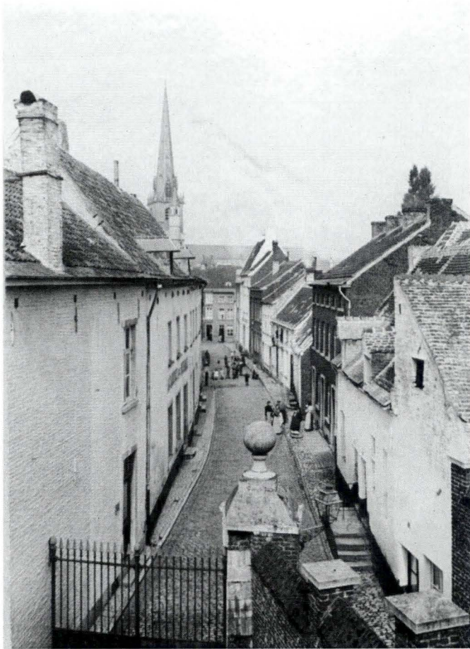
La rue du Wichet à Nivelles.
