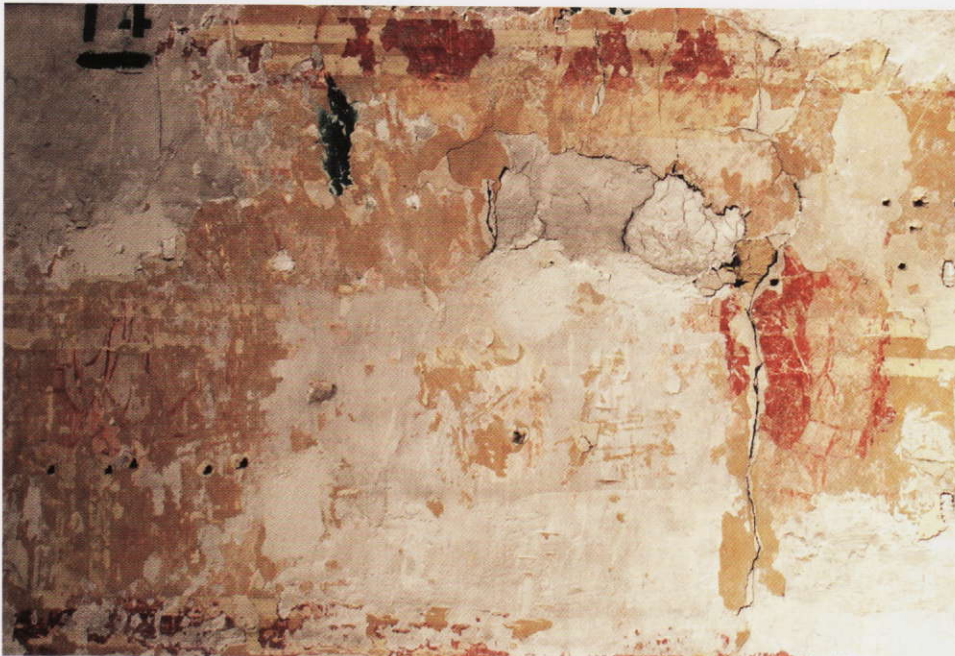
Fig. 12.- Chapelles du bras nord du transept, face sud du pilier séparant les deux chapelles. © Aline Wilmet.
