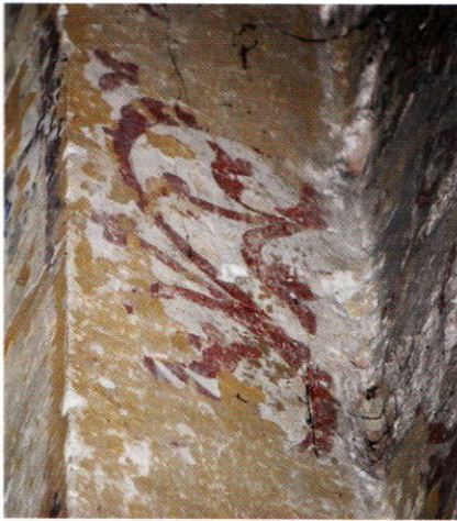
Fig. 5.- Bras nord du transept, bas-côté occidental, retrait du pilier sud, frise de rinceaux ocre rouge sur fond blanc appliqué sur le faux appareil. © Aline Wilmet.
