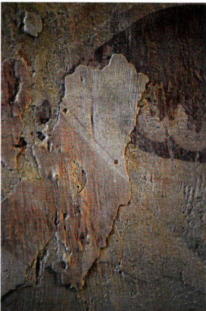
Fig. 6.- Bras nord du transept, saillie nord du pilier nord entre le vaisseau central et le bas-côté ouest, motif de frise noduleuse du premier décor recouverte des vestiges du faux appareil et d'un troisième décor décoloré mais tracé plus finement. © Aline Wilmet.
