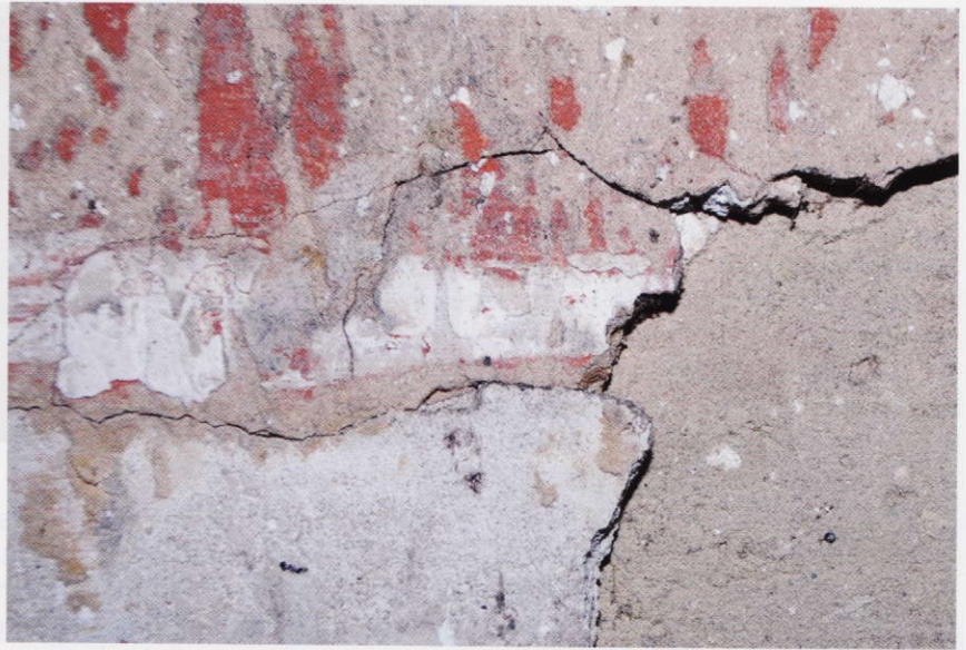
Fig. 2.- Bras nord du transept, partie est de l'arc diaphragme, trois types d'enduits jointifs forment le support de la couche picturale.
