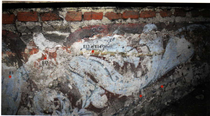
Fig. 19.- Nef, première travée entre la nef et le transept, arc diaphragme, frise végétale bleue sous laquelle on aperçoit encore les rares vestiges de la frise ocre rouge à rinceaux blancs. Localisation des prélèvements de couche picturale effectués sur ce secteur.
