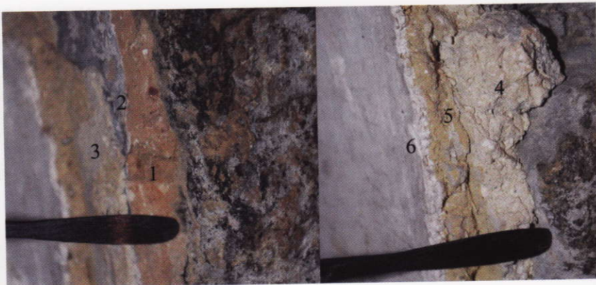
Fig. 3.- Bras nord du transept, stratigraphie du soubassement du pilier nord, entre le vaisseau central et le bas-côté.
